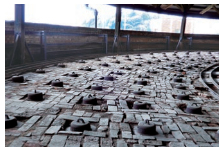
▲天井の上には合計400個の「投炭孔」がある。
