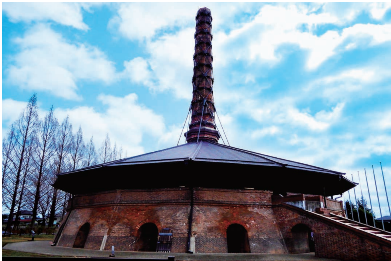
▲野木町煉瓦窯は正確には円形ではなく、16の焼成室がぐるりと環状に連なった「16角形」で、周囲は約100m。中央には高さ約35mの煙突がそびえ立ち、ここから効率的に排煙を行っていた。国の重要文化財で、近代化産業遺産でもある。
