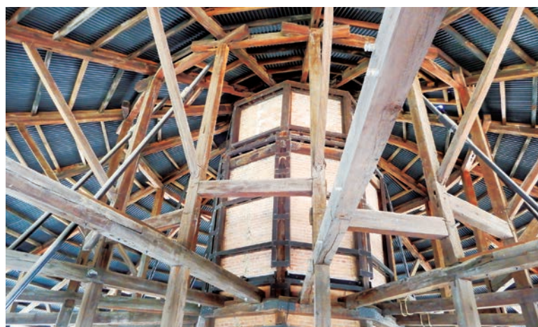
▲窯の上の小屋組みは、木骨トラスが現しになっている。煙突を囲む複雑な構造が美しい。
