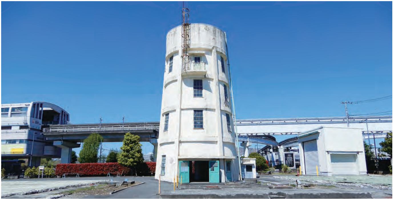
▲給水塔の高さは17.24m。左に見えるのが、多摩モノレール高松駅で、車窓からも給水塔を眺めることができる。
