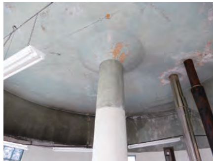
▲各階は中央に柱が1本。上端がじょうご状になって上階の床を支持している。
