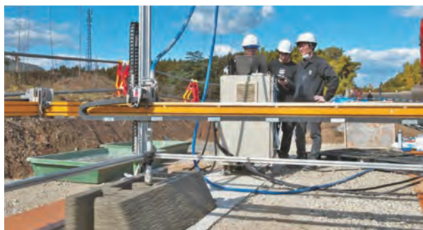
オンサイトプリンティングで製作した重力式擁壁。2025年11月撮影(写真:生田 将人)
