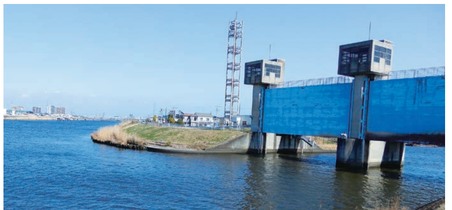
▲ 閘門橋から1キロちょっとのところにある新大場川水門。閘門橋は逆水止めの役割をこの水門にゆずった。写真左側が中川、水門側が大場川。
