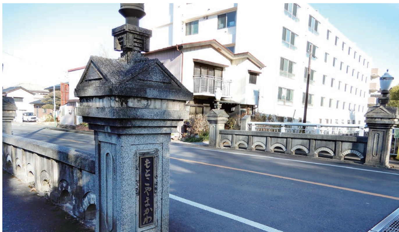
▲賀美橋の上部構造のデザインは幾何学的で、この時代に世界中で流行したアール・デコを思わせる。橋長6.3m、幅員9.0mの鉄筋コンクリート造単桁橋
