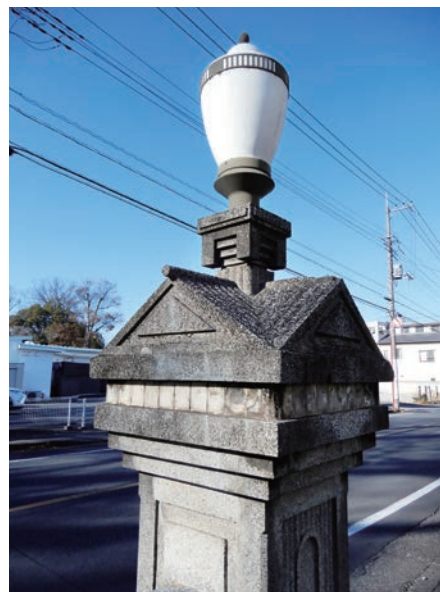
▲親柱の屋根の下の水平材にも、タイルが貼ってあったような跡がある
