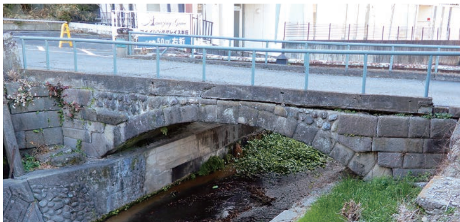
▲寺坂橋。かつては親柱と中柱、高欄も石造だったという。アーチ両側の付け根の「輪石」に五角形の切石が使われている。橋長7.5m、幅員3.5mの石積単アーチ橋
