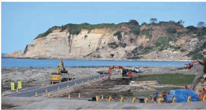
■隆起した海岸に応急復旧の道路を整備する様子 (写真:日経クロステック)
