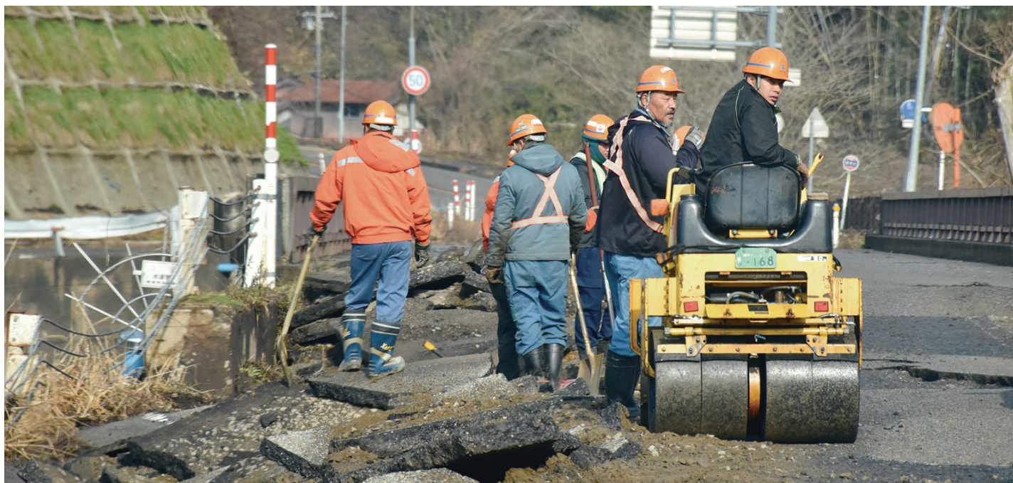
■石川県輪島市内での道路啓開作業の様子。2024年1月6日撮影
