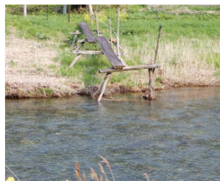
▲ 4月の大雨で流されてしまった松日橋。水に浸からないところは残った
