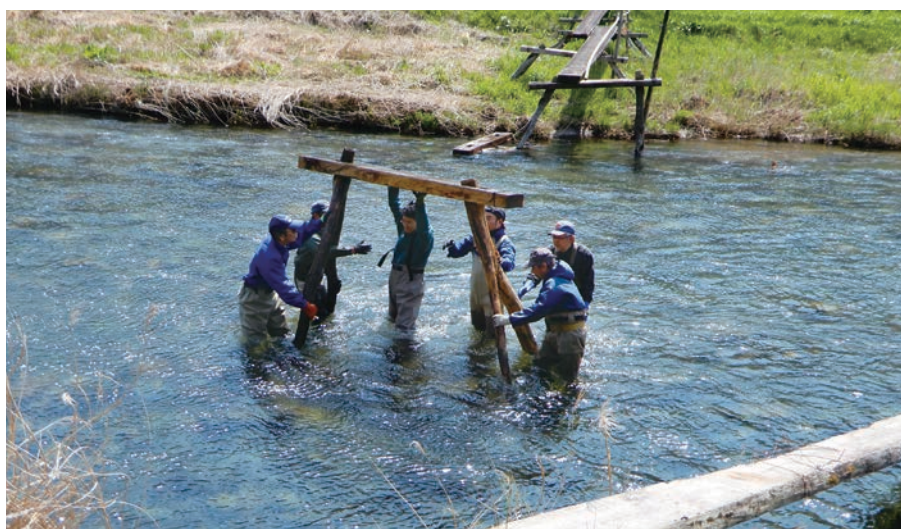
▲ 地域の人たちによる橋架け作業の様子。胴付き長靴姿で川へ入り、倒れたり、流されたりしたザマザを組み直し、位置を調整する
