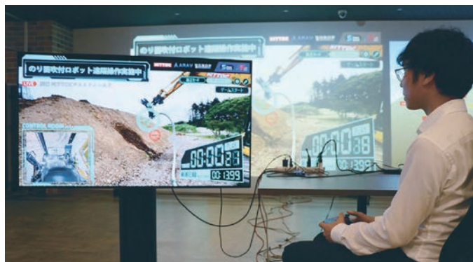
■ 遠隔施工の事例。「法面吹き付けロボット」を操作する様子 (写真:日経クロステック)
