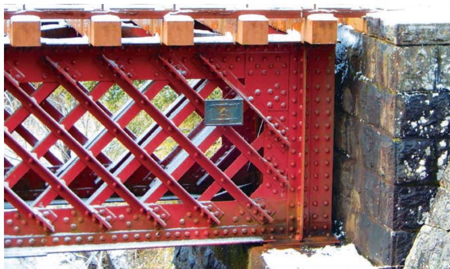
▲徳佐川橋梁の腹板は山形鋼を格子状に組み上げたラチス桁。交点に規則正しく並ぶリベットもドボかわいい
