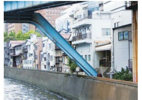
▲左岸側の橋脚は堤防の外側に設置してある。
