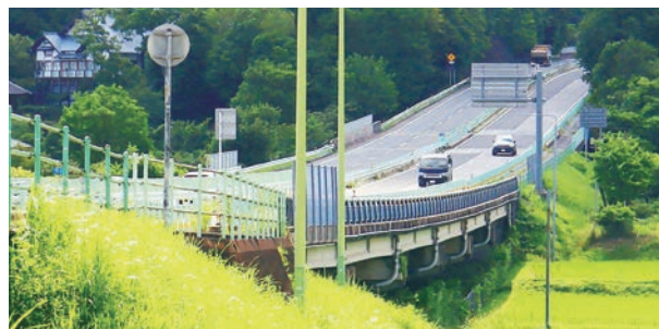
実証現場となった有料道路の猿投グリーンロード。供用中の路線だ(写真:日経クロステック)
