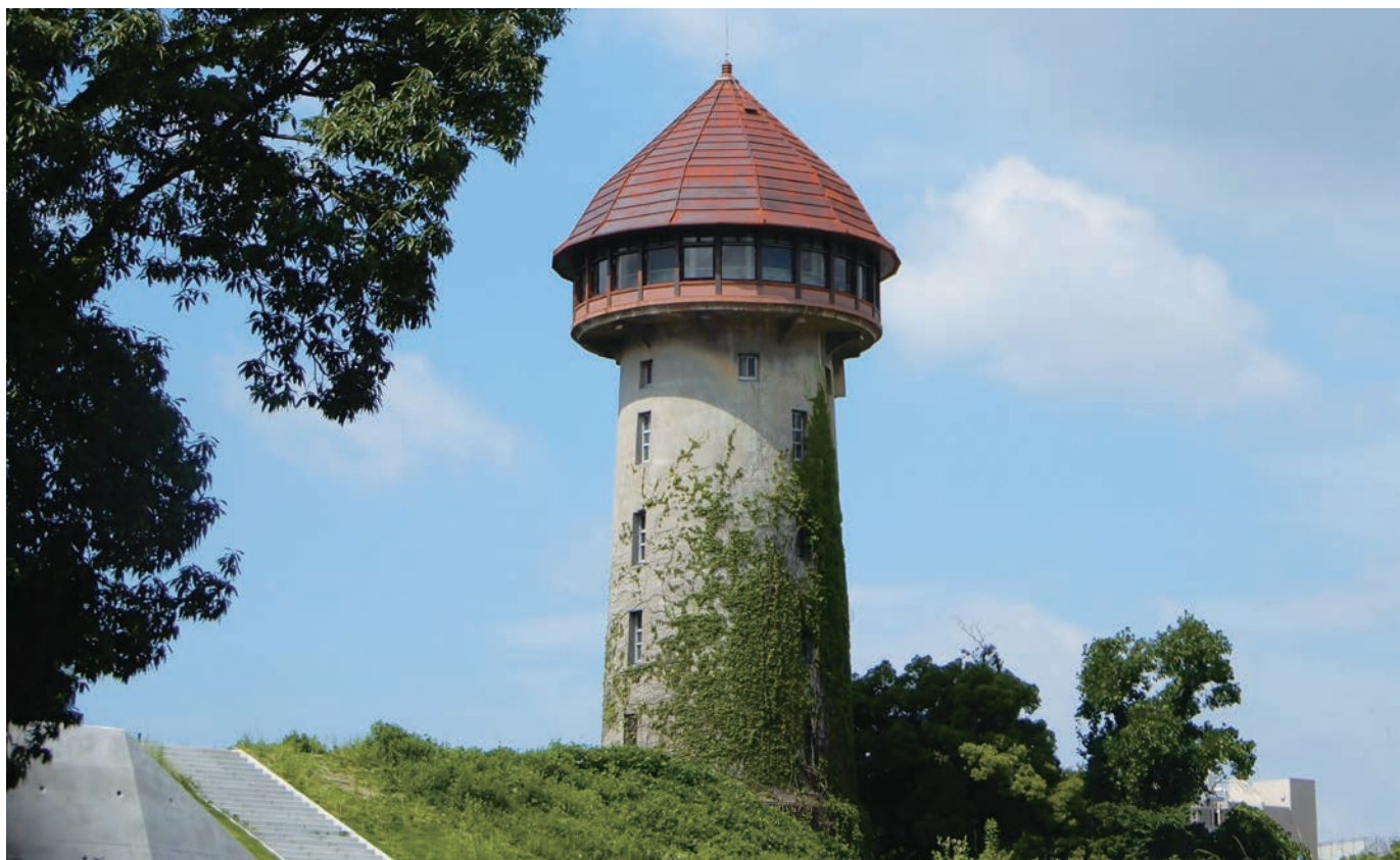
▲赤いとんがり屋根がチャームな東山給水塔。5階の上に水を貯める直径8.4m、高さ7.2mの貯水タンクが載っている。ここに、313m 3 の水を貯め、高台の住宅へ配水していた。現在は一般公開されていない。
