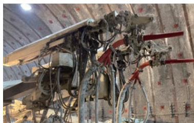
「A 4 CSEL for Tunnel」で用いる2ノズル自動吹き付け機。山岳トンネル切り羽へのコンクリート吹き付けを自動化する (写真:日経クロステック)
