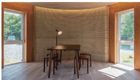
Lib Workが開発した3Dプリンター住宅「Lib Earth House "modelA"」。土を主原料とした材料を積層して造形した。建物内部には、木や土などの自然素材に囲まれた空間が広がっている(写真:日経クロステック)
