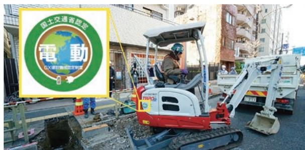
国土交通省関東地方整備局が発注した東京都内の電線共同溝の工事で、初めてGX建機が導入された。試掘作業で竹内製作所の電動バックホー「TB20e」を用いた(写真:日経クロステック)
