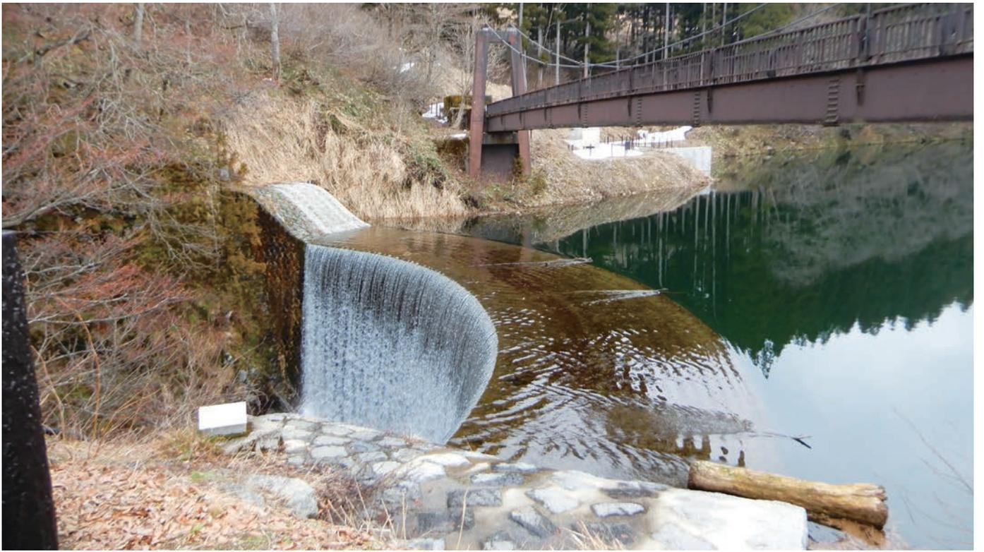
▲大源太川第1号砂防堰堤の全景。カットしたバームクーヘンを思わせる。老朽化により、堤体の厚みを増強する工事が行われた。上の吊り橋は「希望大橋」。
