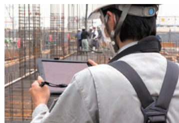
● タブレット型施工管理システムの現場での活用例 (写真:筆者)
