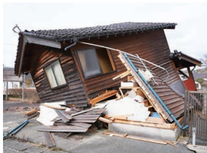
能登半島地震で倒壊した、石川県穴水町にある木造戸建て住宅。プレカットの加工などから、1981～2000年に建てられた新耐震基準の建物と見られる(写真:2点とも日経クロステック)
