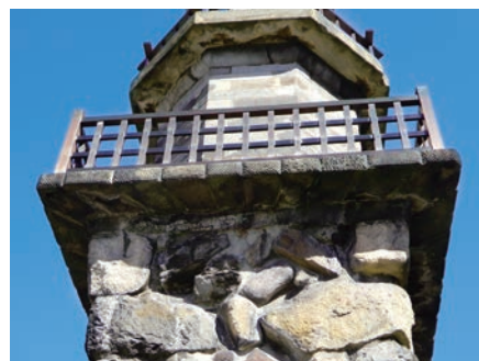
▲自然石の乱石積みで方形の基壇から、切石積みで八角円筒の灯室へ切り替わる。
