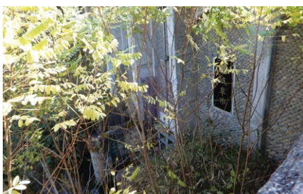
▲ロボット水門と同時期につくられた第二樋門。壁は玉石張りで、川原石が埋め込まれている。
