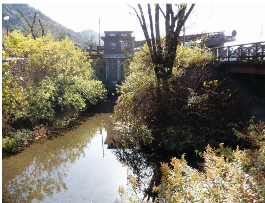
▲忠節用水と放水路の分岐地点。用水は左側の第二樋門を通して灌漑に使用される。余水は右の水路の先にあるロボット水門から放水路へ流される。
