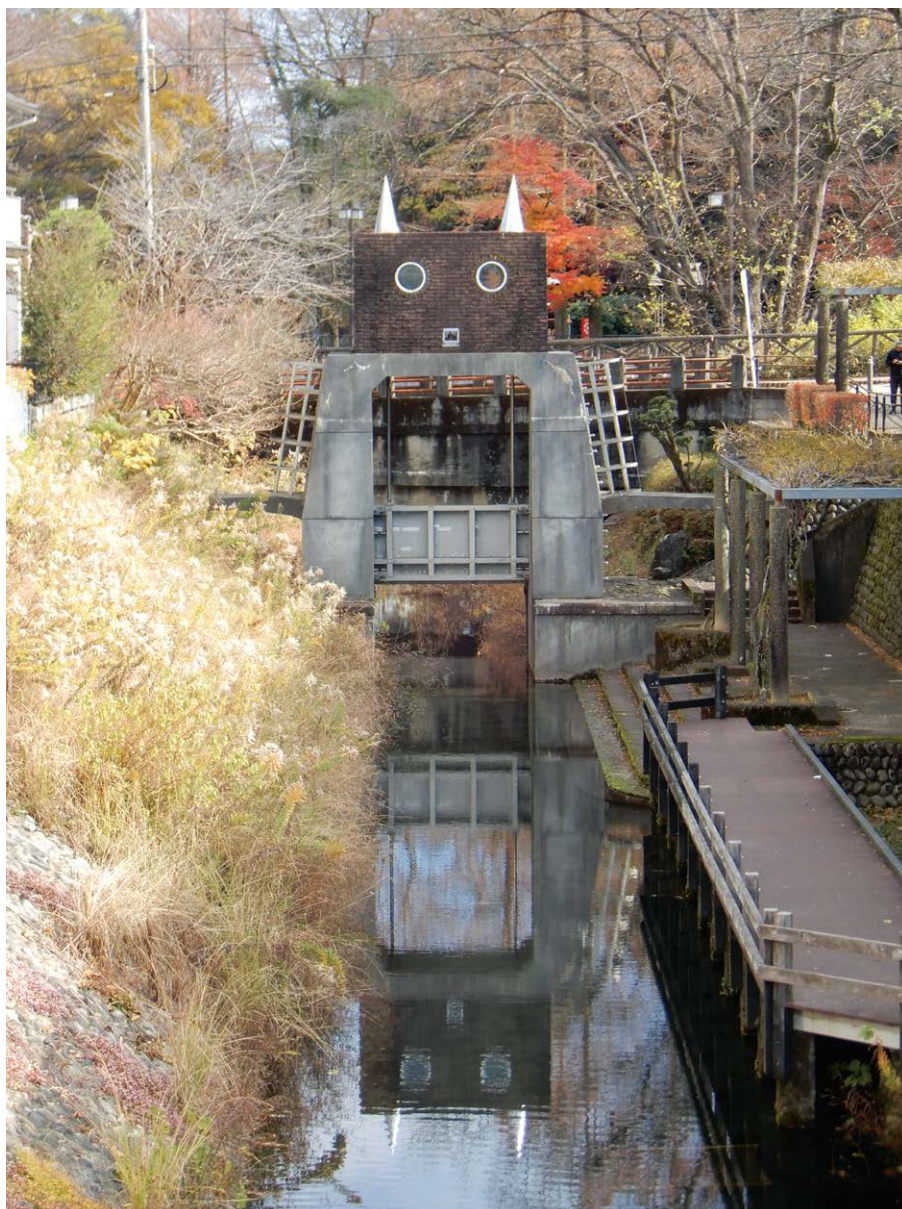
▲ロボット水門の全景。水面に映った顔もまたかわいい。ステンレスの“耳”は装飾ではなく、ゲートを上下させるシャフトの突出部分のカバーで、1992年の改修工事で取り付けられたものだという。
