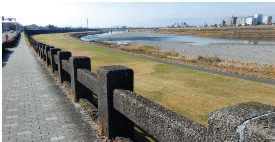
▲岐阜県岐阜市を流れる長良川。ロボット水門のある忠節用水は、長良川から取水し、長良川へ排水する用水路だ。
