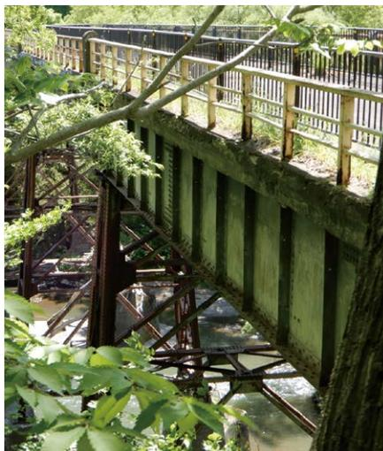
▲ 桁の形式は鋼プレートガーダー。長さ20mの鋼板を9本連ねてある。
