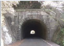
徳島県南部に現存する、延長87m・幅員5.8mの直線状の松坂隧道。日本最古の現場打ちコンクリート造りの道路トンネルとして、国の登録有形文化財に指定されています。「竣工したのは1921年。当時、日本では未知の領域であっただろう工事に果敢に挑戦した土木技術者たちがいたことに、ただただ敬服するばかりです」(写真提供:株式会社姫野組)
