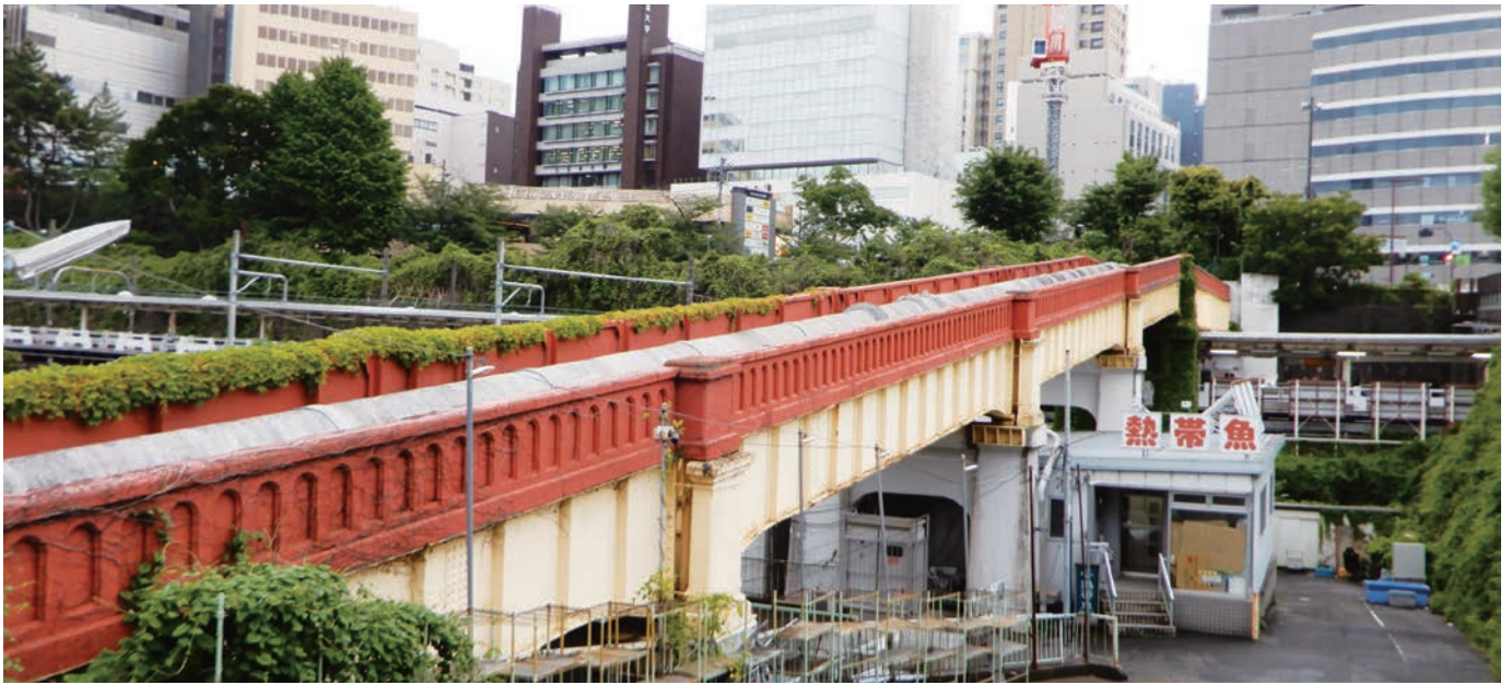
▲ 平行に架かる市ヶ谷橋のたもとから見た市ヶ谷水管橋の全景。手前側に外濠、奥にはJRの線路がある。奥から手前にかけて橋が傾斜しているのが分かる。
