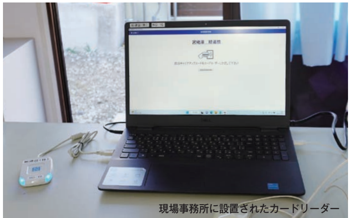
宮崎県「令和4年度宮崎港（仮称）緑道橋橋脚下部工工事（P1橋脚）」
