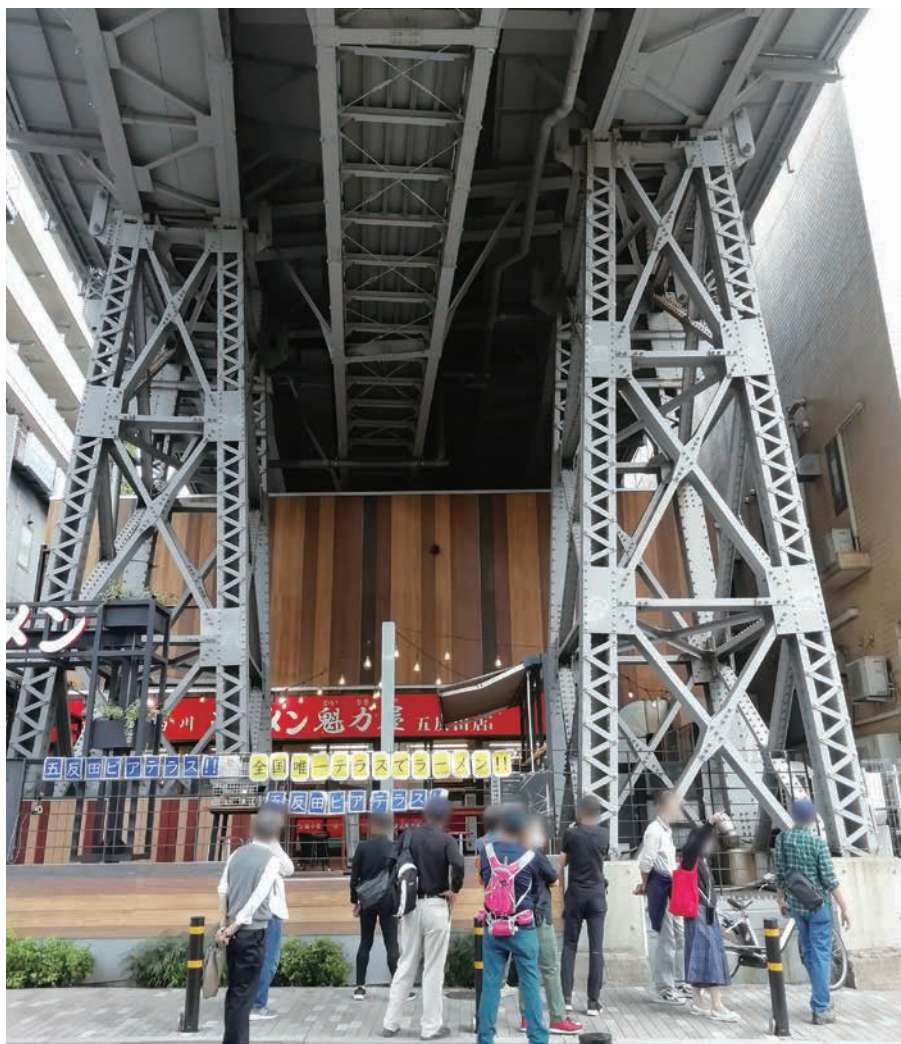
▲高架下はラーメン店になっていて、トレッスル橋脚を間近で堪能できる。ラーメン構造の下にラーメン店とは、ドボク通好み(両者の間に特別な関係はない)。
