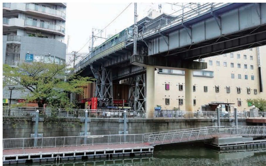
▲目黒川の対岸から、池上線五反田駅方向を見る。奥の2基がトレススル橋脚。川寄りの橋脚は鉄筋コンクリート造に置き換えられている。
