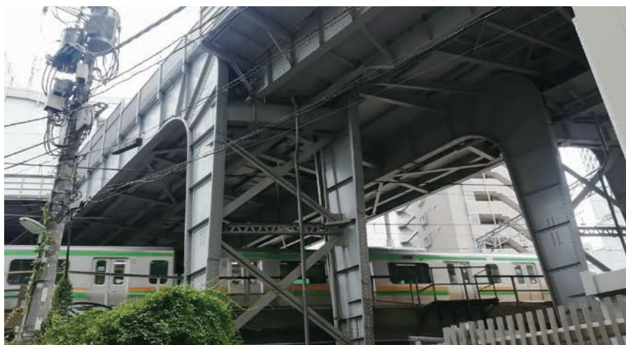
▲池上線が山手線などJRの線路をまたぐ部分は、がっちりとした鋼製のラーメン橋。ここへのアプローチ部分がトレッスル橋で設計された。
