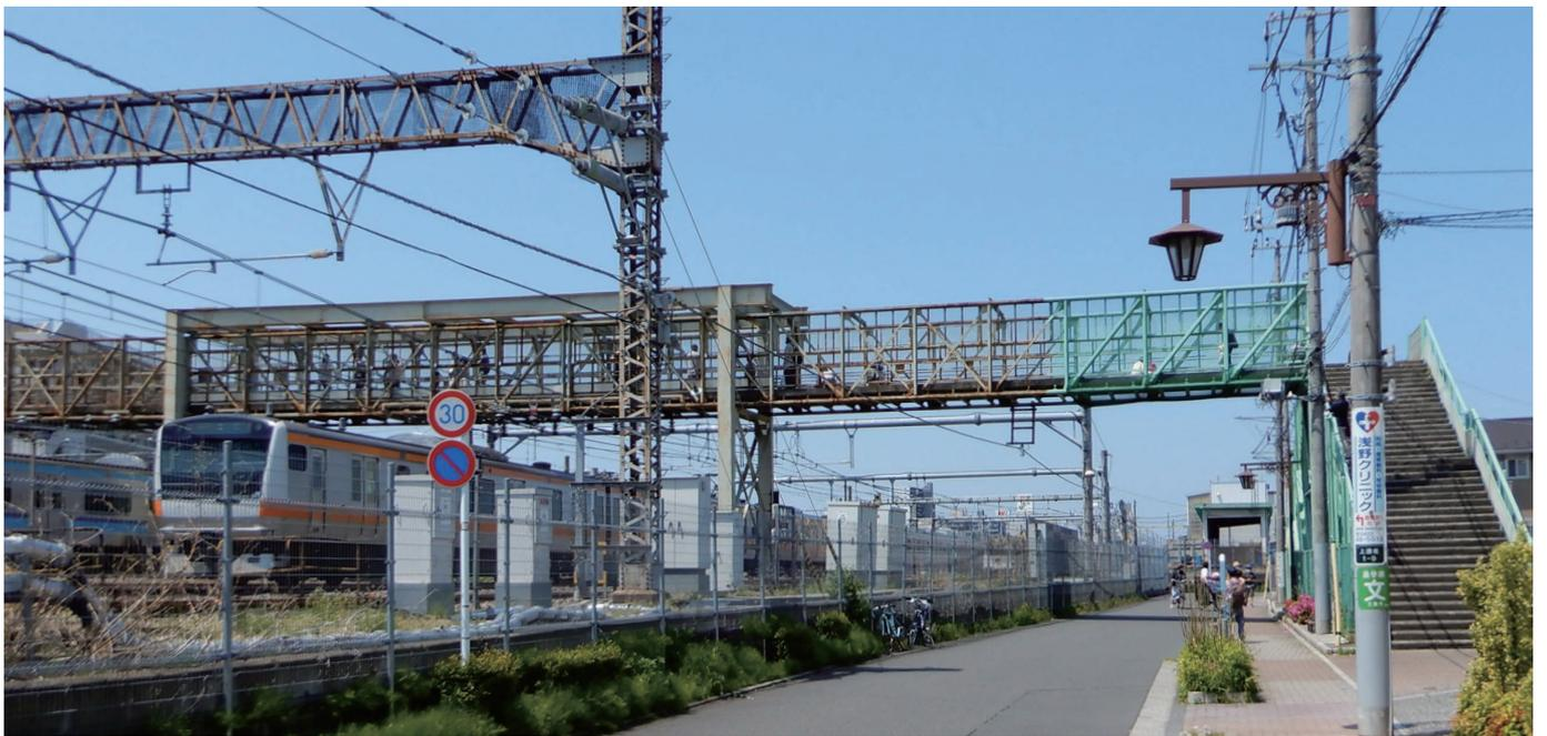
▲北東側から見た跨線橋。オレンジラインの電車が中央線。その線路上空にあたる部分は、門型の橋脚で補強されている。生前に橋上で撮影された太宰の写真には、プラットトラスの「逆ハの字」がはっきり写っていたが、今は斜材が足されて「X字」になっているので少し分かりづらい
