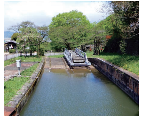
▲復元されたインクラインの台車。琵琶湖疏水の水力発電で巻き揚げ機を動かした。
