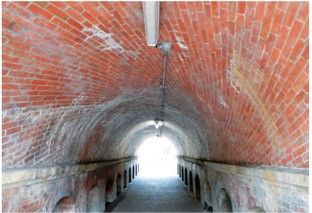
ねじりまんぼの内部。側壁との接続部を見ると、レンガが斜めに積まれているのがよく分かる。側壁に並んだ小さなアーチもドボかわいい。上は琵琶湖疏水を指揮した田辺朔郎の銅像。
