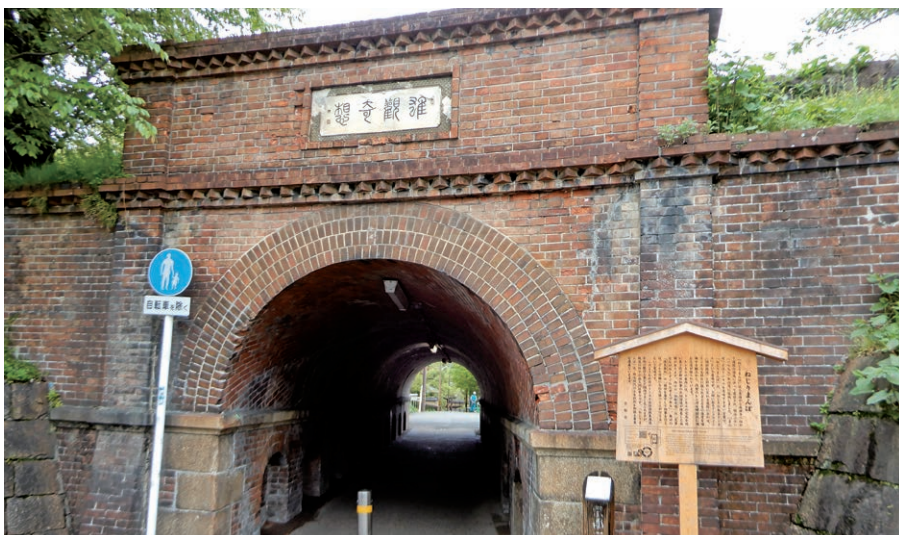
▲ねじりまんぼの三条通側の坑口。扁額の上にはレンガをノコギリ状に積んだ装飾「デンティル」が配されている。
