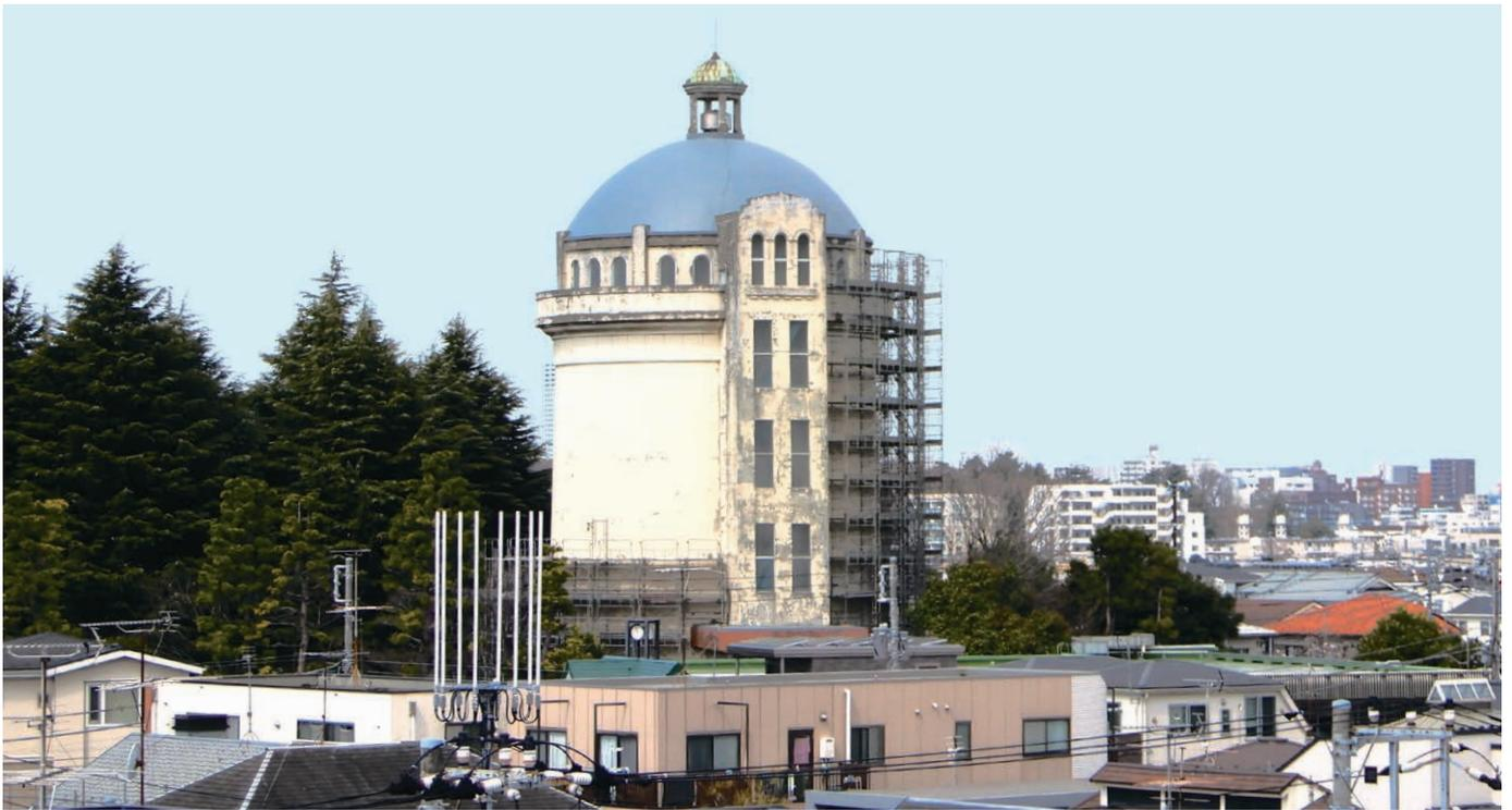
▲ 野方配水塔の容量は2784m<sup>3</sup>で、同じ大きさの大谷口配水塔と合わせて人口60万人に対し2時間分の水を貯めることができた。正面の凸部分は階段室。補修のため北側は足場に覆われていた。
