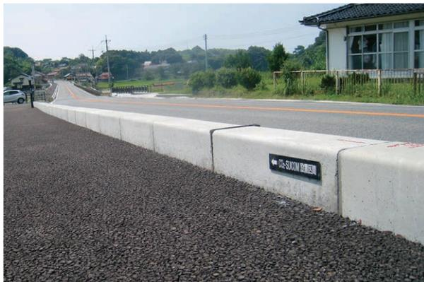
島根県の国道の歩車道境界ブロックに「CO<sub>2</sub>-SUICOM」を適用した例(写真:鹿島)
