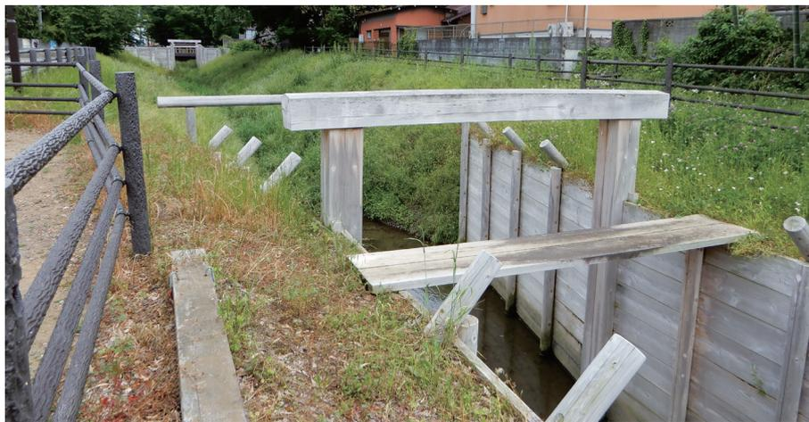
▲見沼通船堀東縁の閘門(一の関)。奥に小さく見えているのが二の関。一の関を船が通過した後、鳥居型の門柱に角落しの板を取り付けて、二の関が通過できるようになるまで水位を上昇させる。
