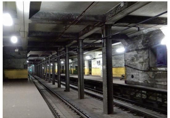
▲ 鉄骨の柱・梁でトンネルを支える鉄鋼框。
