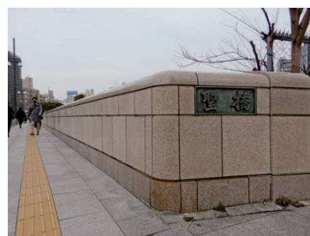
▲ 端に設けるのが一般的だった「親柱」をあえて廃したシンプルな高欄。
