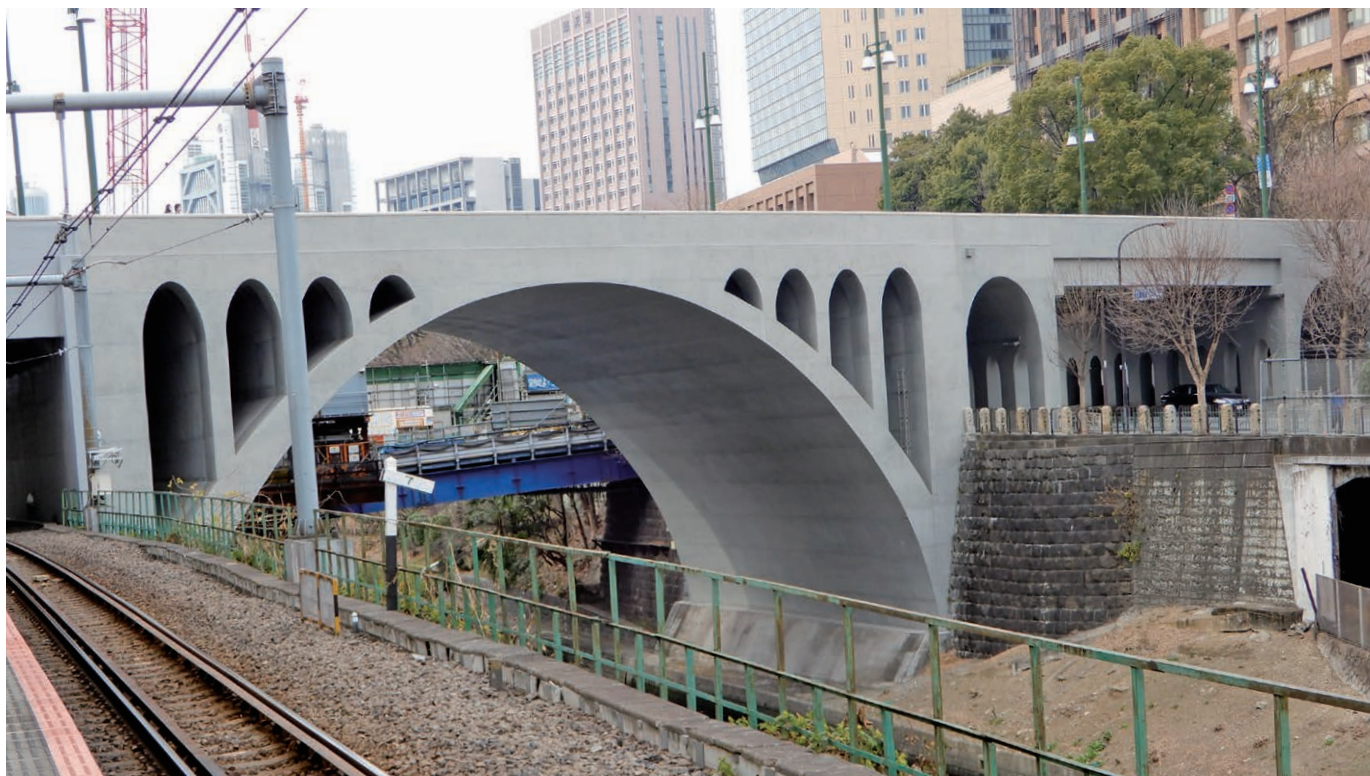
▲ 聖橋の全景。両側の側径間の主桁は鉄骨だが、コンクリートで被覆し、中央のアーチと一体感を出している。2018年に長寿命化工事が完成した。
