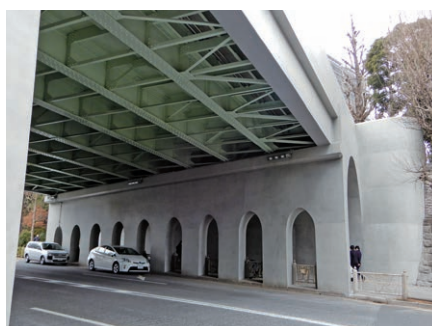
▲ 外堀通りをまたぐ側径間部分。橋台にも小さなアーチが配されている。
