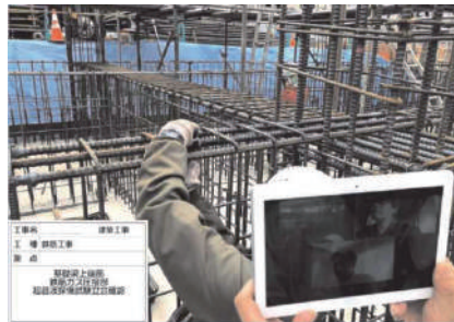
Webカメラを利用した遠隔検査
