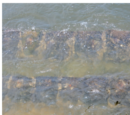
▲ 関東大震災で沈下した開港初期の石積み護岸の一部が保存されている。
