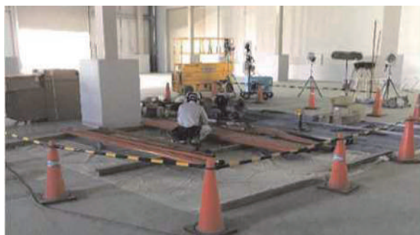
工事エリアの区画を設定して作業
