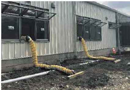
送風機を稼働し、埃を外部へ排出
