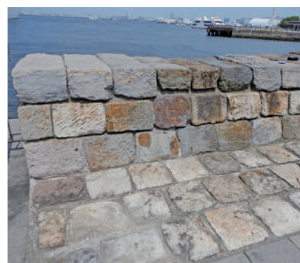
▲ 復元した部分にも古い石積みが使われた。
