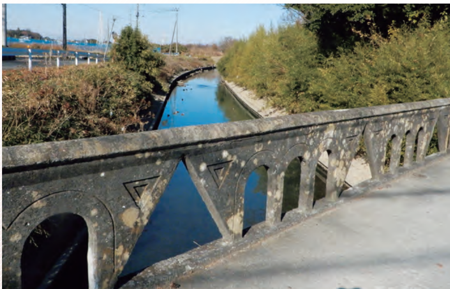
高欄の中柱は半球を伏せた下に丸太状のコンクリートが置かれ、側面にはレリーフがある。
