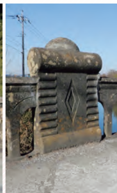
高欄の中柱は半球を伏せた下に丸太状のコンクリートが置かれ、側面にはレリーフがある。
