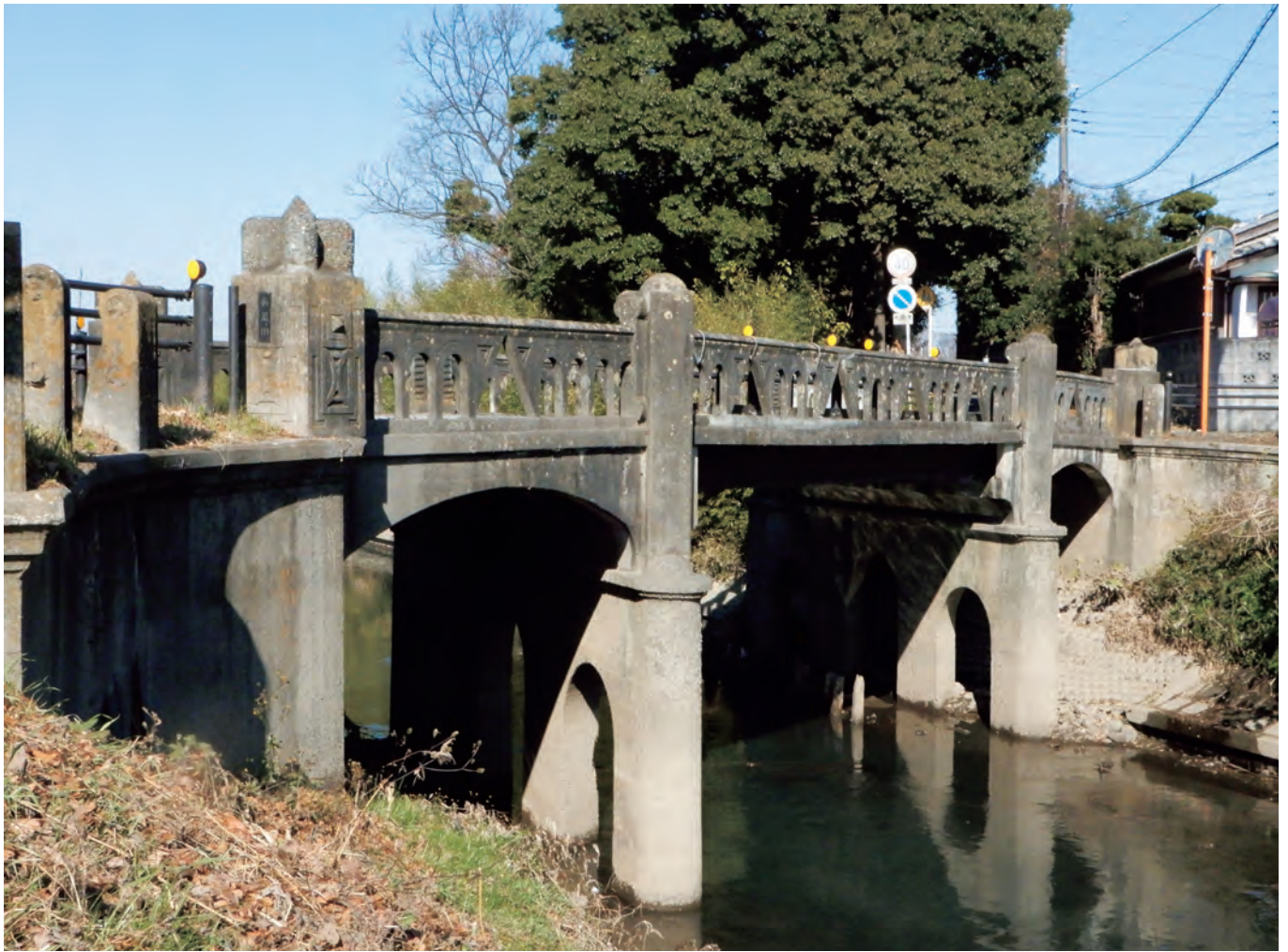
堀切橋の全景。橋台は軟弱地盤に強いラーメン構造になっている。橋名は、戦国時代に石田三成が行田の忍城を水攻めした際、この近くで堀が切れて失敗したことに由来するという。
