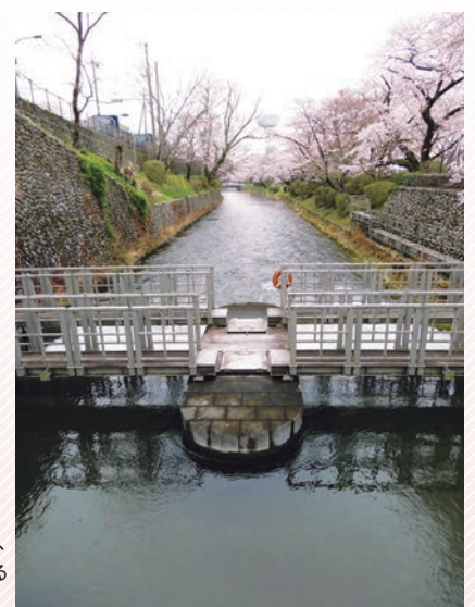
第二水門から玉川上水を見る。第二水門は、角材を積み重ねることによって川を締め切っている。「角落とし」の構造だ。
