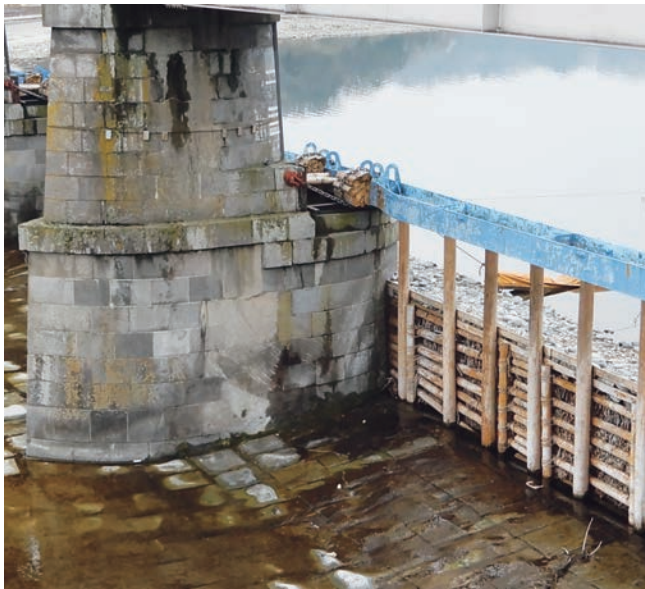
コンクリートの支柱の間に、鉄の桁を渡し、丸太の垂直材で投渡木(横架材)を支える。大水のときには、桁と丸太を外して投渡木ごと川に流してしまふ。
