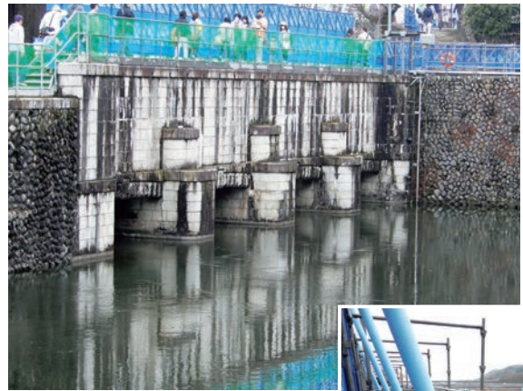
現在の第一水門。右の写真の開閉装置で17のゲートを上下させて流量を調節する。
