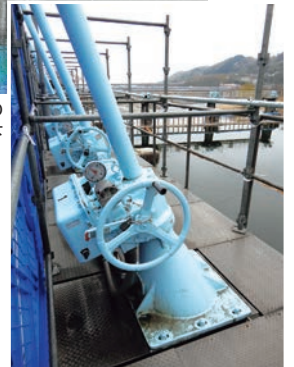
現在の第一水門。右の写真の開閉装置で17のゲートを上下させて流量を調節する。
