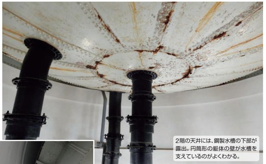
2階の天井には、鋼製水槽の下部が露出。円筒形の躯体の壁が水槽を支えているのがよくわかる。
