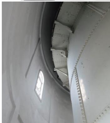
2階からバルコニーのレベルの上行くと内部にも回廊があり、水槽の側面が見える。接合部がリベット止めになっているのは、鋼製水槽の特徴だという。
