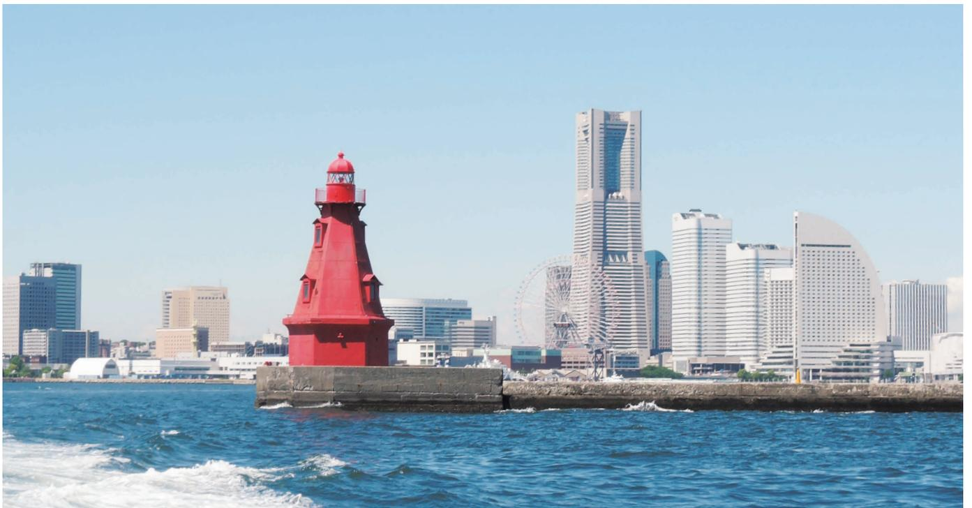
▲ 125年にわたり横浜港の入口を示し続ける赤灯台。高さ15m。防波堤はコンクリートブロックを製造して積んだ。
