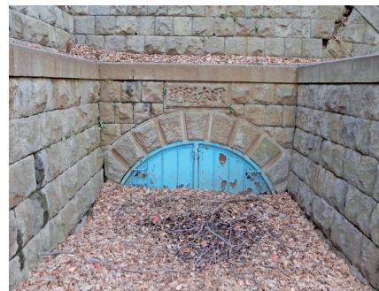
▲ 駒沢給水所の次に標高の高い場所は丘の下にトンネルを掘って水道管を通した。入口に「岡本隧道」と彫ってある。
