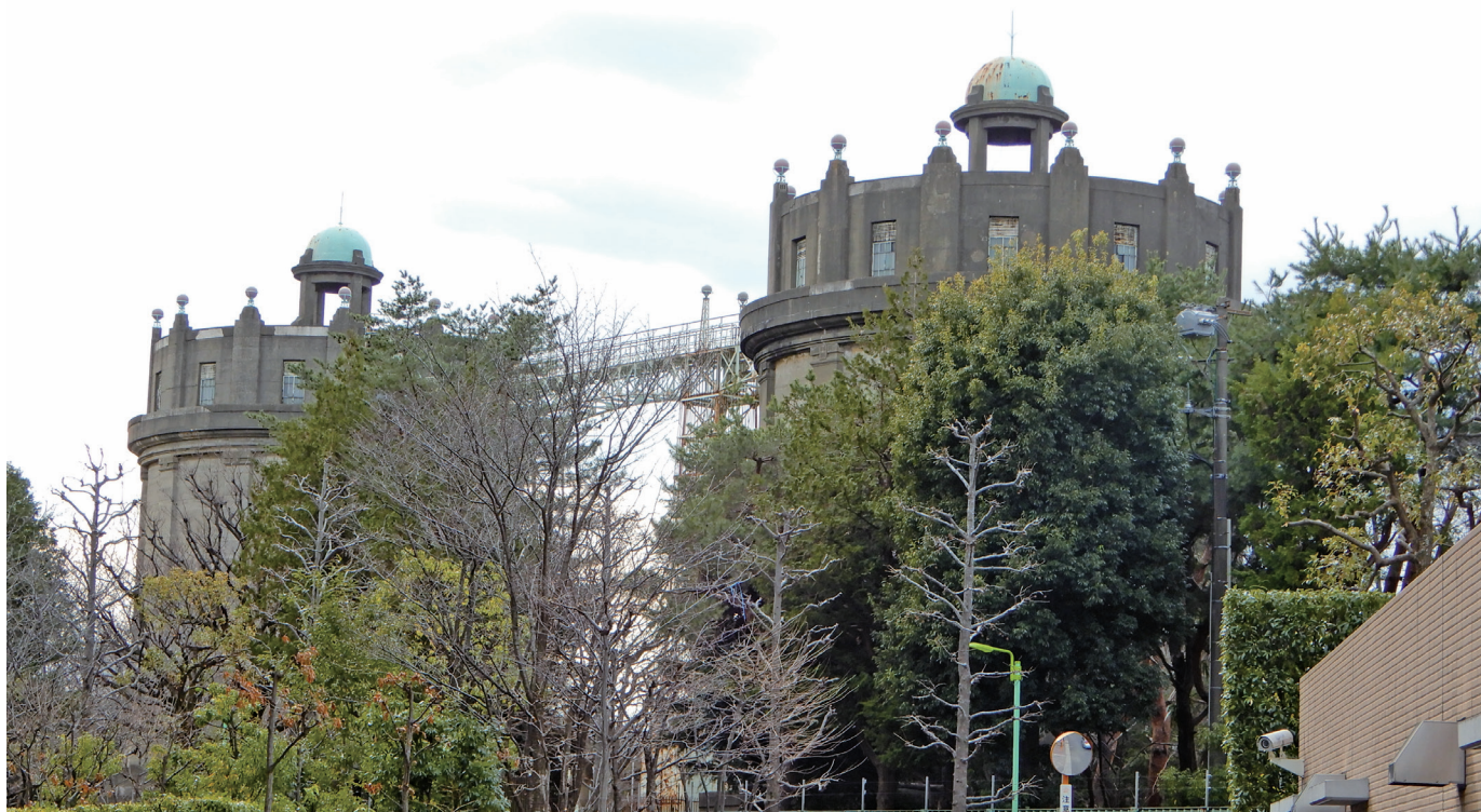
▲ 2基の配水塔はトラス橋でつながれており、屋上へ向かう外階段とつながっている。現在はセキュリティ上、駒沢給水所の一般公開はされておらず、眺望を確かめられないのが残念だ。
