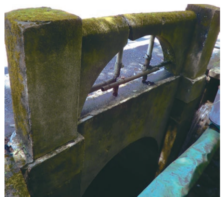
▲山側から見た森越橋。欄干と桁の下がダブルのアーチになっている。
