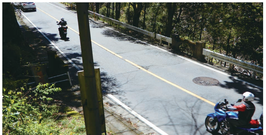
▲ 道の両側のガードレールが途切れた部分に欄干が見える。長さより幅のほうがずっと広い。
