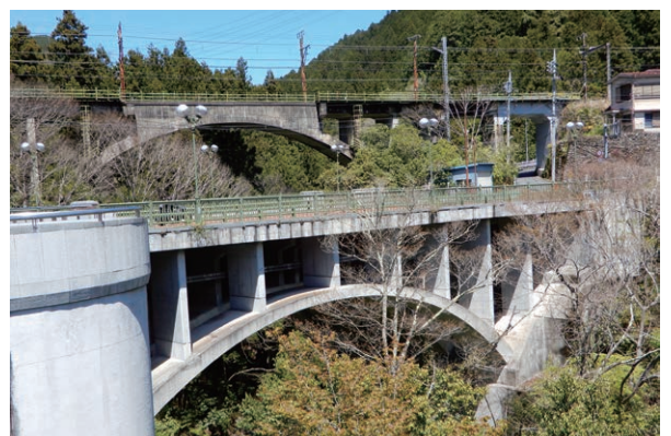
▲ 手前が大正橋、奥は青梅線の大丹波川橋梁。川井地区に架かる橋はすべてアーチ橋に統一されている。
