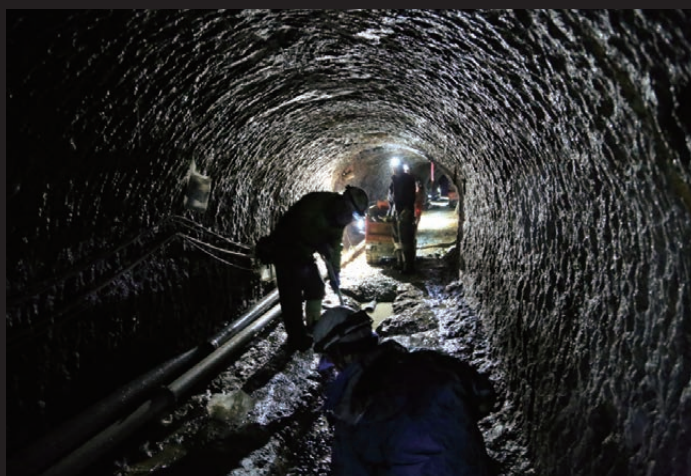
水路トンネル・写真集「インフラメンテナンス」より
