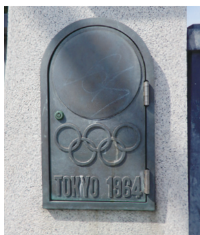
▲ 親柱の側面にある照明の点検口の扉には、亀倉雄策デザインのエンブレムが配されている。
