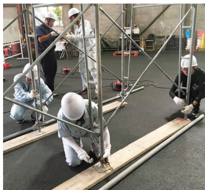
足場組立実習
