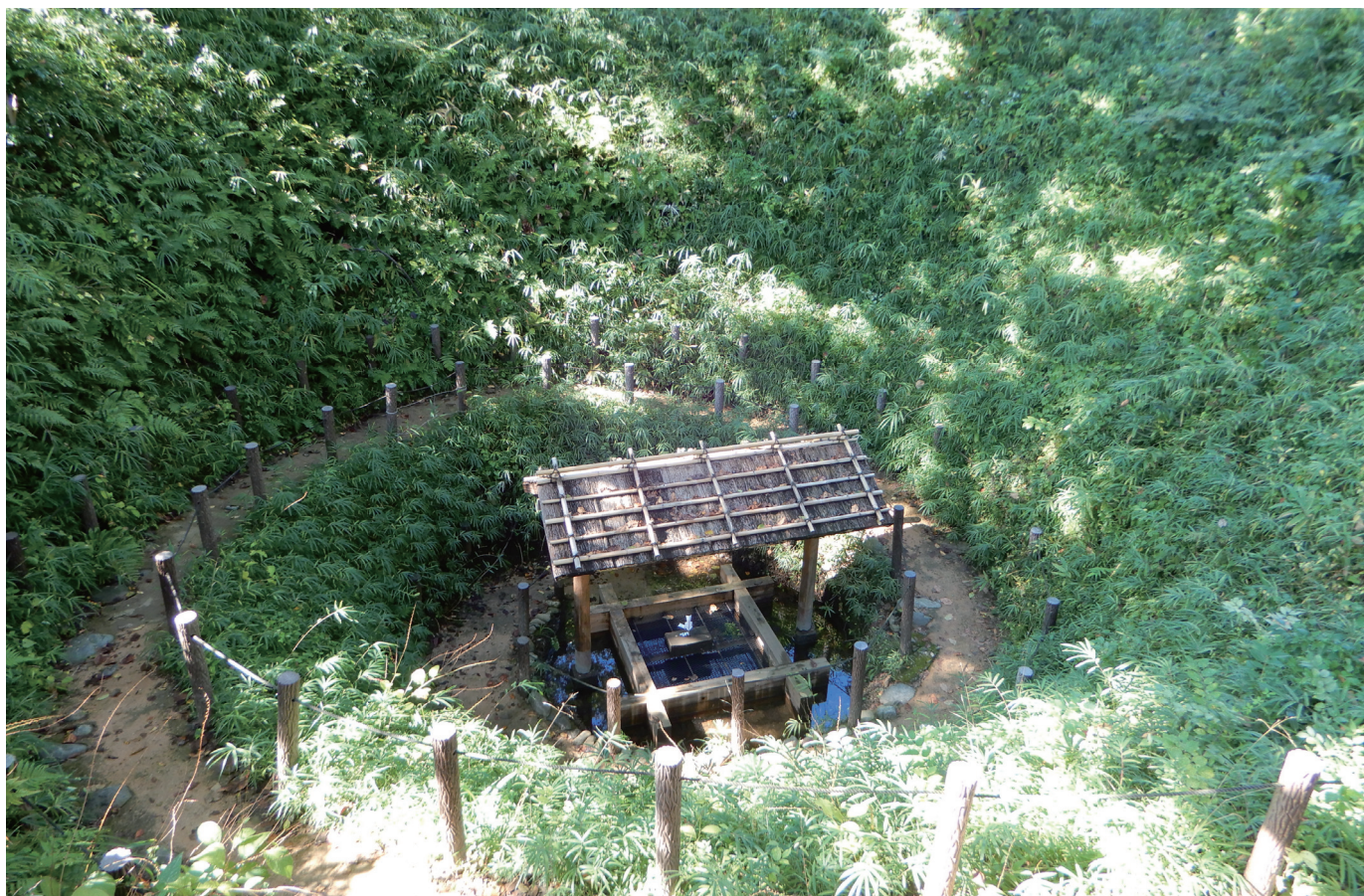
▲ 五ノ神まいまいず井戸の全景。螺旋状の通路を降りていくと、少しずつ見える景色が変わって楽しい。筒井戸は石垣になっており、周囲の地山から湧き出す水を濾過するために、砂利が裏込めしてある。
