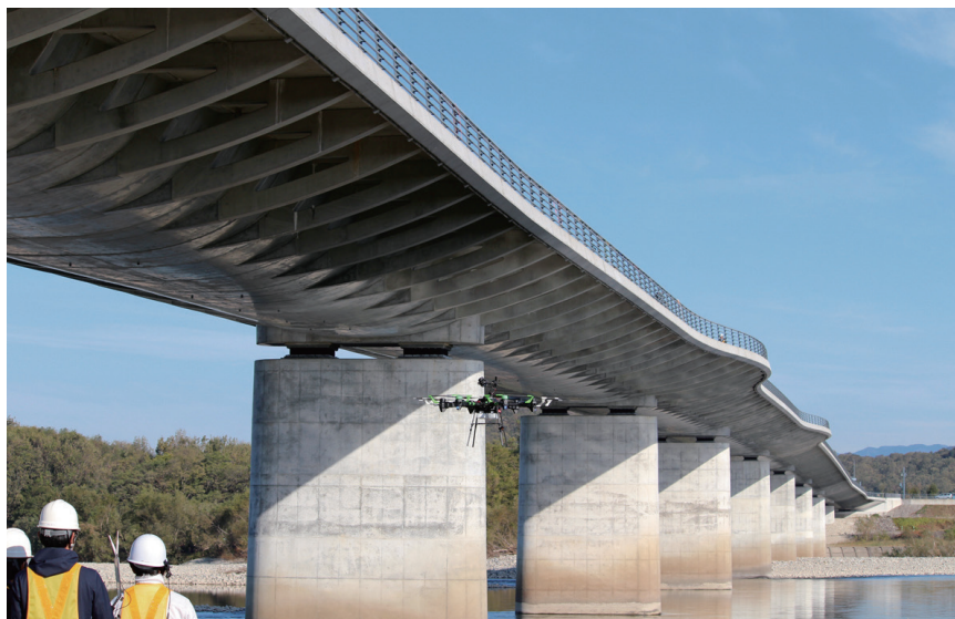
定期点検にドローンを活用した各務原大橋(写真:岐阜大学)
