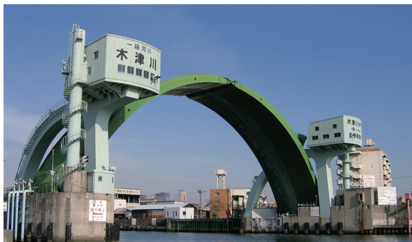
大阪府が更新を進める予定の三大水門の1つ「木津川水門」(写真:大阪府)
