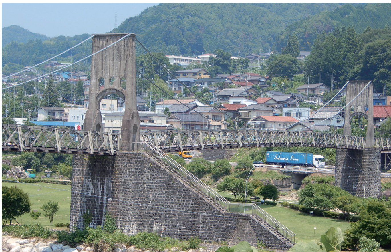
▲ 3本のうち中央の主塔(画面では左側)には中洲へ下りる階段が付いている。主塔の側面にこのための開口部を設けたことが、構造上の弱点になってしまったという。そうだとっても、橋の真ん中から階段を下りて行けるのは楽しい。
