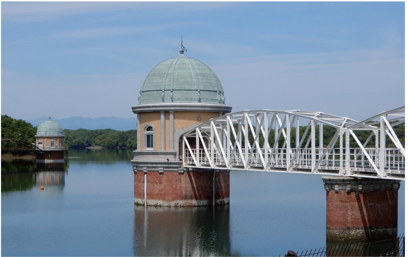
▲タイル張りの外壁やドーム屋根、アーチ型の窓などが印象的な村山下貯水池第一取水塔。入り口の上には明治期に誕生した東京都の紋章がついている。管理用のプラットラス橋の造形も美しい。奥には第二取水塔がある。
