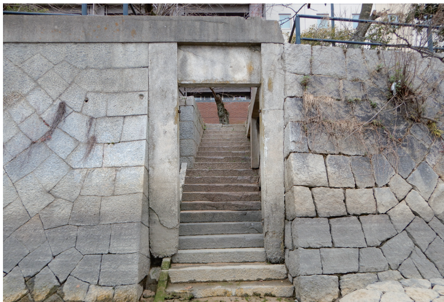
▲京橋川右岸の雁木の一例。向かって左側は石同士が密着しているのに対し、右側は隙間が広いなどの違いがある。
