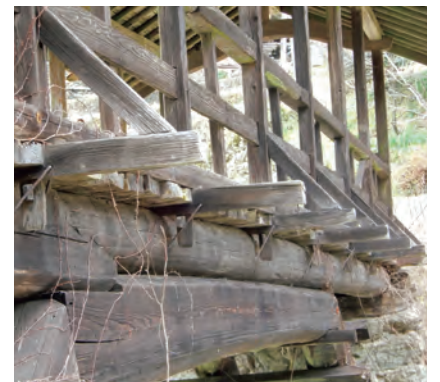
屋根を支える柱の基部を横材と斜材で補強している。
