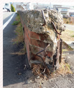
「金森式鉄筋レンガ」で築かれた堤の端部から鉄筋が覗く。
