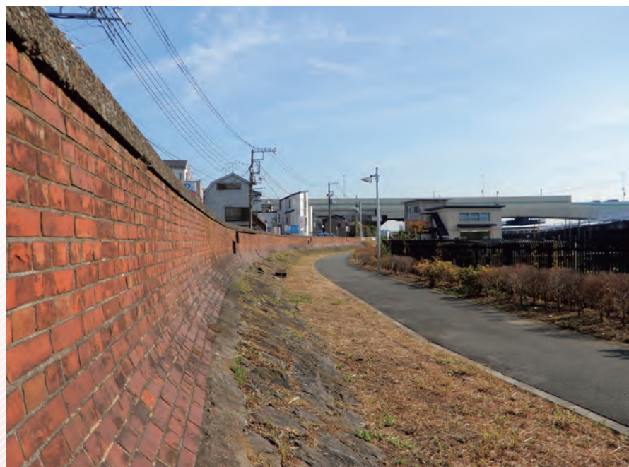
大師橋のたもと、東京・大田区側に残る多摩川の旧レンガ堤。右側が川で、今は堤外に道路が通っている。
