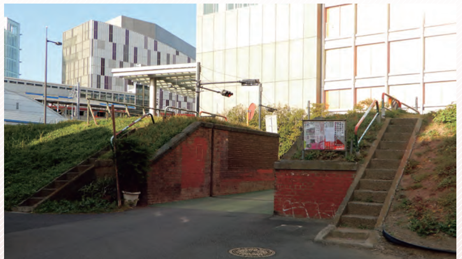
東急二子玉川駅付近には旧堤防と2カ所の陸閘が残っている。洪水時には溝の部分に板をはめて浸水を防く。
