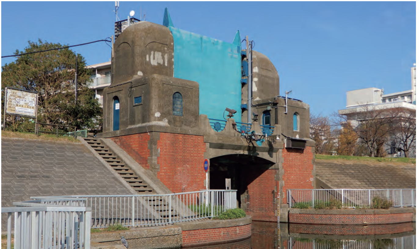
多摩川側から見た六郷水門。六郷用水の排水口に、船を通すために設けられた。コンクリートの丸いフォルムと、門扉の“猫耳”が印象的だ。
