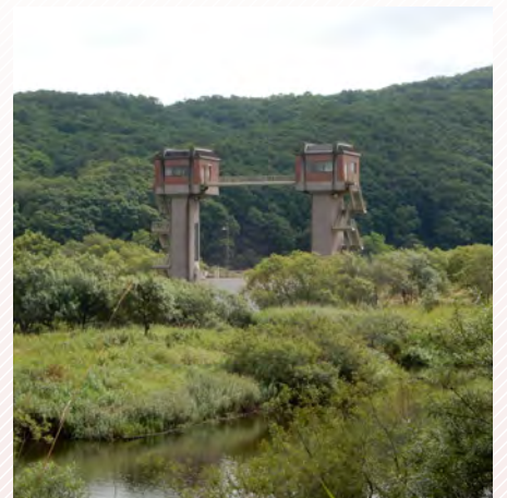
1985年に完成した新岩保木水門。無人で遠隔制御しているという。
