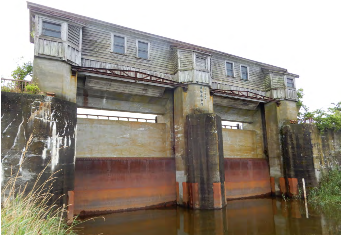
正面から見た岩保木水門。木造の上屋は度々が補修され、趣のある姿を保っている。中には扉を上下させるための手動巻き上げ機が4基格納されている。
