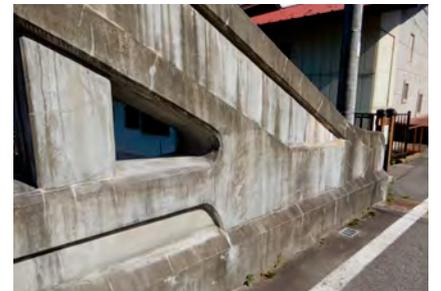
側面にはコンクリートに凹みが施されている。重量を軽くするのが目的だが、意匠性にも配慮している。
