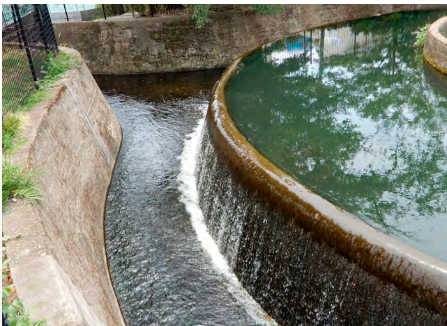
外側の円筒の縁を越流した水が堀へと流れ落ちる。コンクリートの素朴な曲面が味わい深い。
