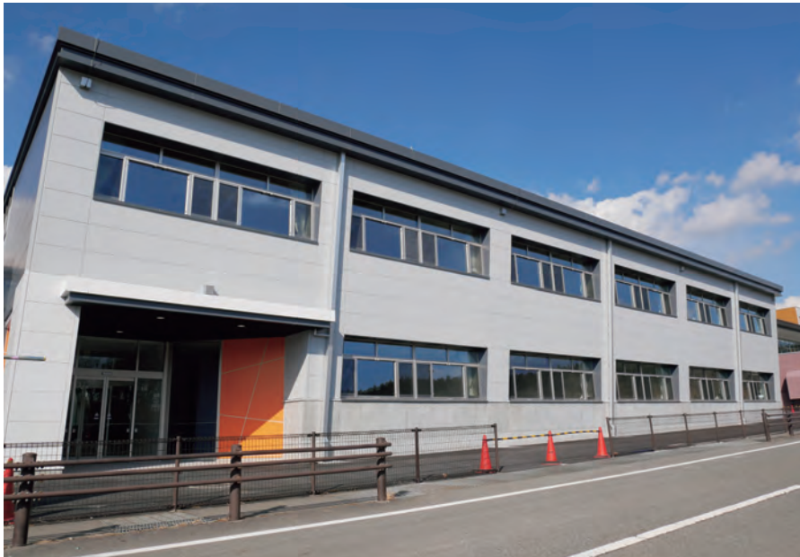
教室棟南側外観 エントランスにオレンジのポイントカラー
