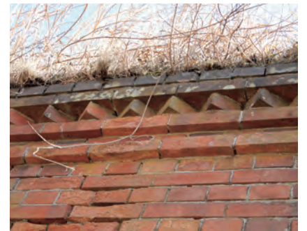
御庄野橋梁の上部には、煉瓦の角を三角に見せた「蛇腹」を挟んである。
