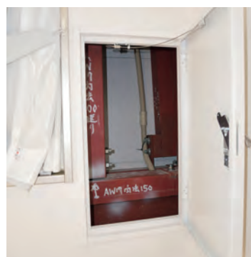
鉄骨、外壁などの取り合いが見える化
