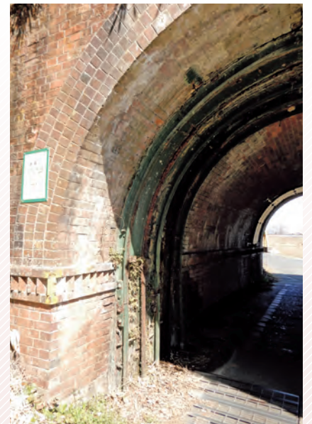
国分橋梁の内部には、レール材で補強が施されている。
