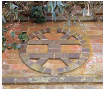
国分橋梁の上部に施された関西鉄道時代の社章。黒っぽい焼き締め煉瓦で凹凸をつけ、周囲から浮き上がらせている。
