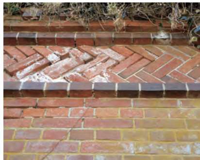
新道橋梁の煉瓦は、上部がヘリンボーン状の飾り積み、その下はイギリス積み。
