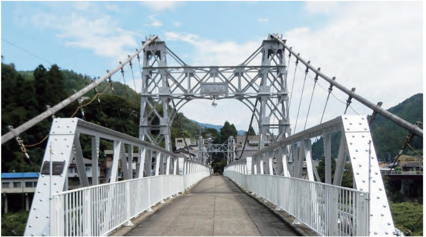
橋長115m、幅員4m。約10mの高さの鋼トラス主塔2本でケーブルを吊っている。当時の欧米風のモダンなデザインだが、材料も含めて純国産だ。2006年に土木学会選奨土木遺産、2013年に国の登録有形文化財にそれぞれ指定された。
