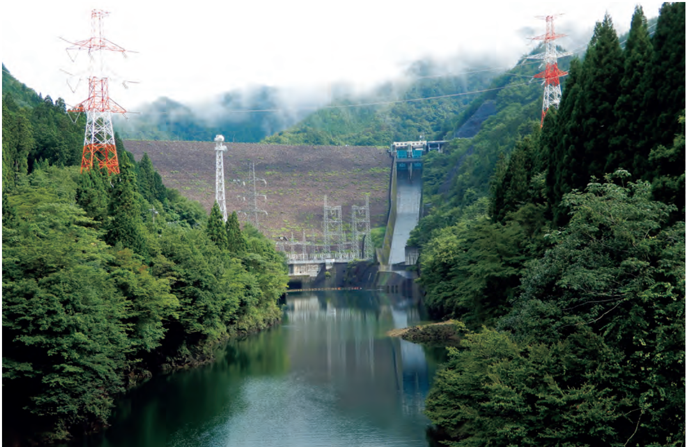
岩屋ダムの全景。左岸側に設けられた洪水吐きは、放水を跳ね上げて拡散するスキージャンプ式減勢工になっている。現地へは、JR高山本線の下呂駅か飛騨金山駅から車で30分程度。
