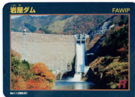
岩屋ダムの全景。左岸側に設けられた洪水吐きは、放水を跳ね上げて拡散するスキージャンプ式減勢工になっている。現地へは、JR高山本線の下呂駅か飛騨金山駅から車で30分程度。
