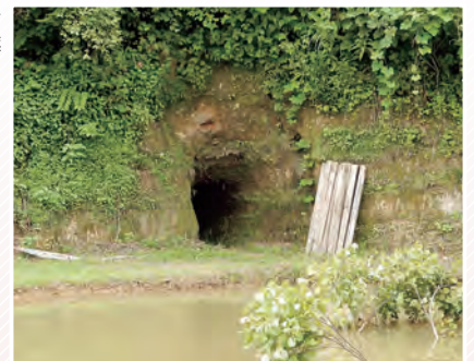
山あいには棚田が点在している。この地域には昔から田を開くときに自分で横井戸を掘り、水を引いていた。中山隧道より60年ほど前に掘られた「水路隧道」も近くに残り、現役で使われている(右)。
