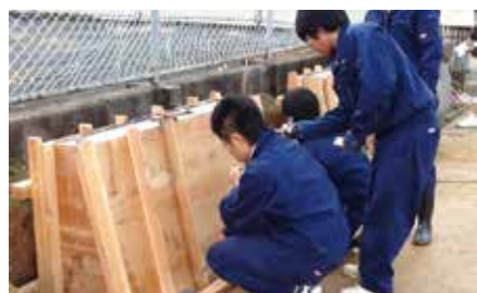
学校内で老朽化していた土壁。新たに擁壁製作をするため、ものづくりマイスター制度を活用し、型枠工事の実技指導を受けた
