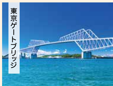
東京港に架かる「東京ゲートブリッジ」。世界最大級の規模のトラス橋で、中央部でトラス桁が途切れた開放的なデザインが特徴。恐竜が向かい合っているように見えることから恐竜橋とも。都内はもちろん、富士山まで見渡せる壮大な景色は見ものです。
